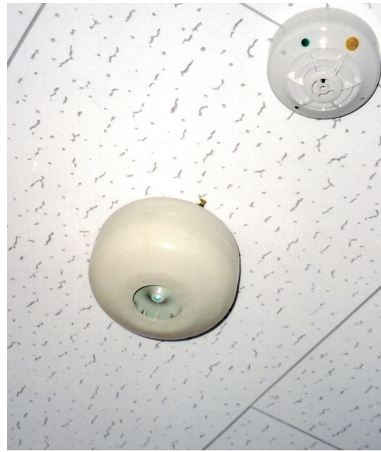
天井引掛ローゼットで設置 ECL-200
