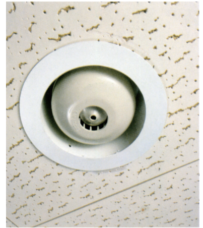
天井埋込みアダプターで設置 ECL-200
